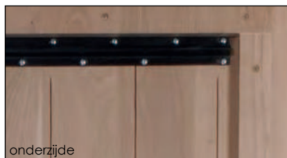
Staalprofielen en ontlastingsleuven
