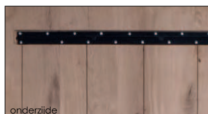
Optie: staalprofielen en ontlastingsleuven
