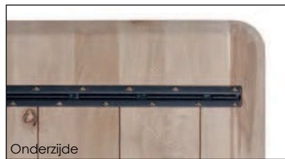
Staalprofielen en ontlastingsleuven
