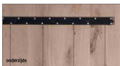
staal profielen en ontlastings sleuven
